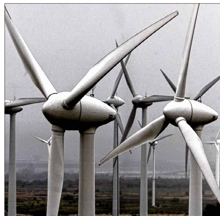
Windräder drehen sich überall – hier ein Bild vom Windpark Ermden. Ein Dresdner Unternehmen will im Windpark Sichau nun den dortigen Windpark erweitern. Archivfoto: David Hecker/ddp
